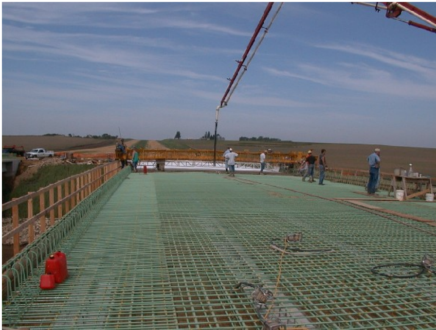
(d) Epoxy bridge (looking west)
