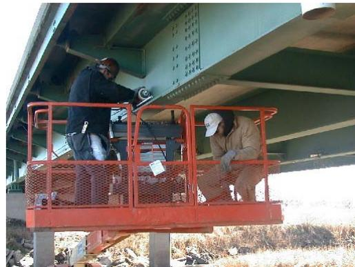
(d) Application of P-T force in Center span.
