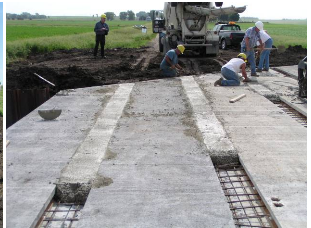
(d) Casting the panel connections
