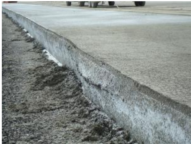
a. Significant edge slump.
