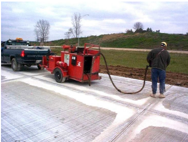
Installing hot pour sealant
